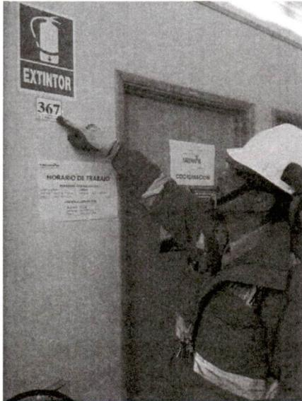
**Paso N° 3.-** Revisar el buen estado de la puerta y mica protectora del gabinete metálico, colgador metálico o pedestal según sea el caso.
